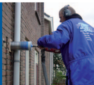
Renovatie- en boorwerkzaamheden
